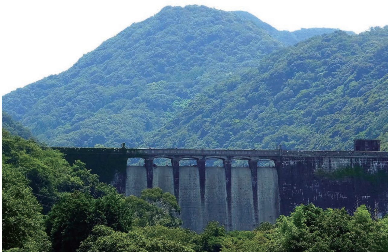
(日本の近代土木遺産上田池ダム堰堤)
